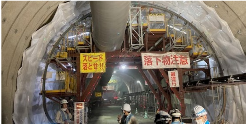
トンネル施工現場における 自走式溶着による遮水シート施工状況例
